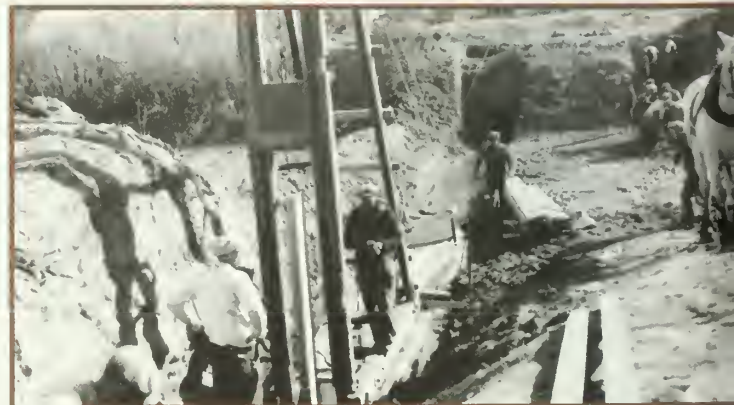
Construction du barrage Melita
